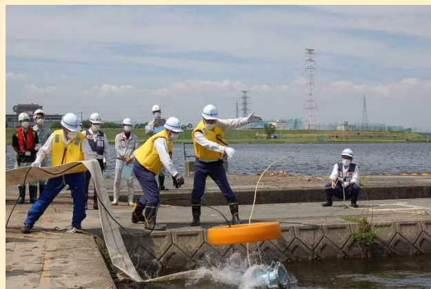
ポンプ投入状況
