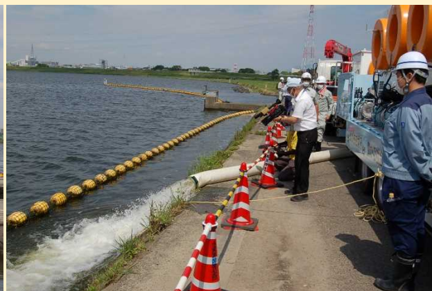
排水状況（約5m 3 /分）
