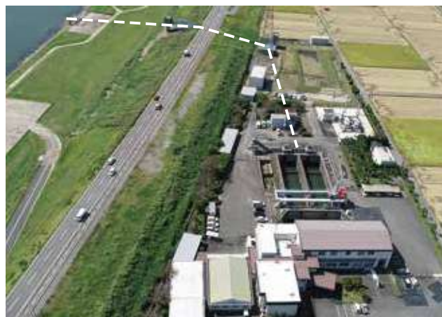
福岡導水管理所全景（取水口～ポンプ場）
