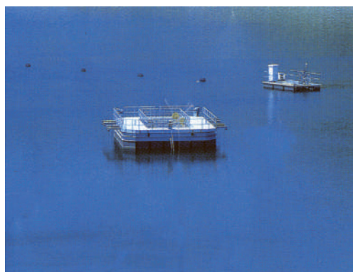
山口調整池の水質保全設備
