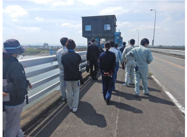
管理橋の確認状況
