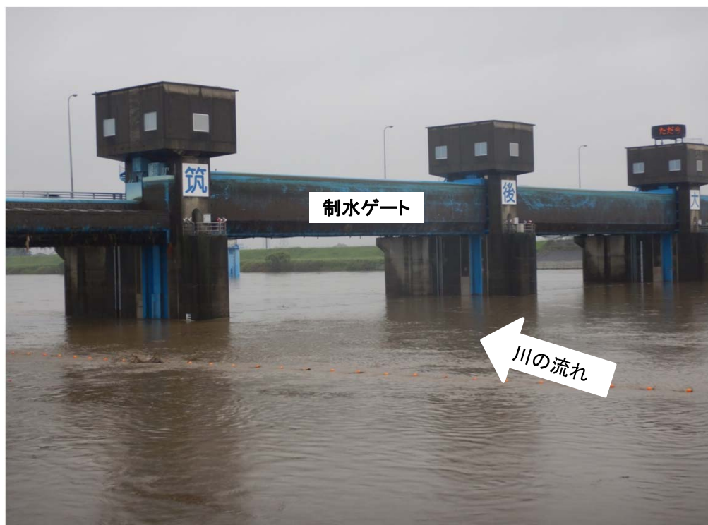
ゲート全開操作開始後の筑後大堰（堰上流側から望む）
