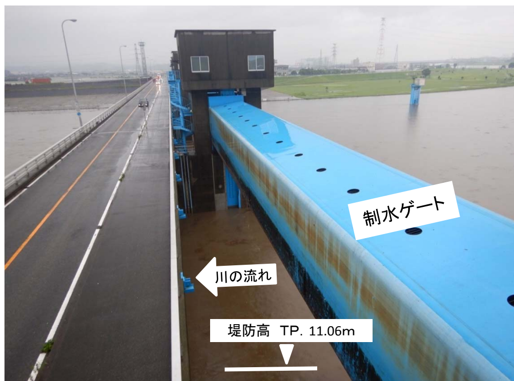
ゲート全開操作開始後の筑後大堰 (堤防高と同じ位置にゲートを引き上げました。)
