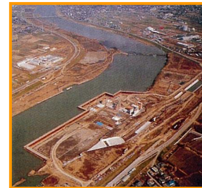
建設中の筑後大堰(1)
