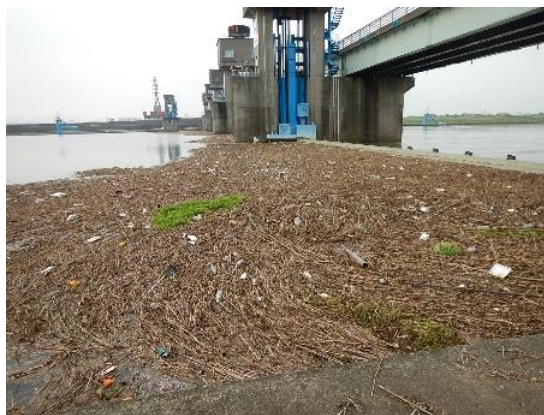
塵芥等の堆積状況
