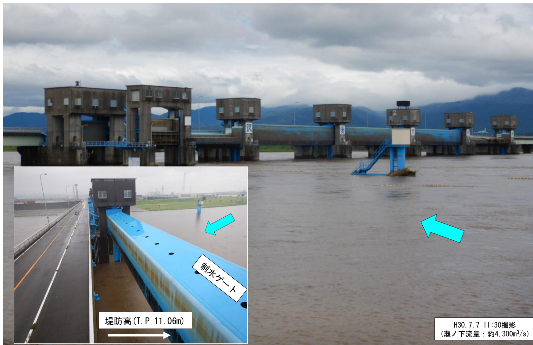
出水時のゲート全開状況 (H30.7)
