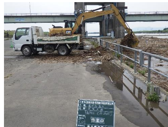
重機による塵芥等の陸揚げ
