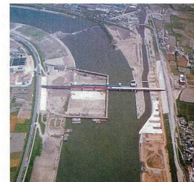
建設中の筑後大堰(2)
