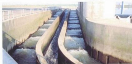
干潮のときの階段式魚道
