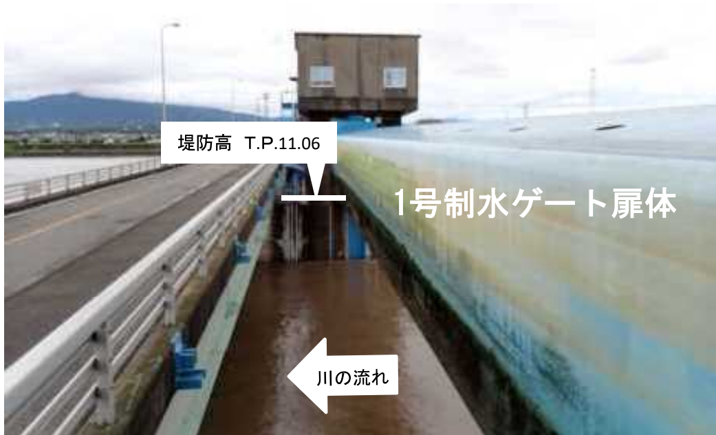
ゲート全開操作開始後の筑後大堰 （1号制水ゲートを左岸から右岸方向に望む）
