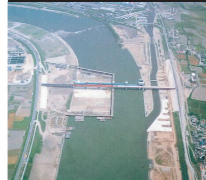
右岸堰柱2基、ゲート3門の据え付け、管理橋5径間の架設を行なった。この他左右岸の取付工事などとともに河道内の浚渫工事を行ない本体工事を完了した。
