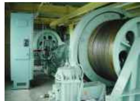
ゲートの開閉装置は、ワイヤロープワインチ式の開閉装置を設けています。ゲートの開閉速度は、毎分0.3mです。なお、閘門ゲートは、船の通航時間の短縮を図るために毎分約1.7mの開閉速度を併用しています。
