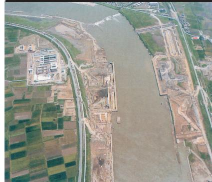
左右岸同時着工とし、右岸側は最小限の施工範囲とし、5月末までに仮締切を撤去した。
