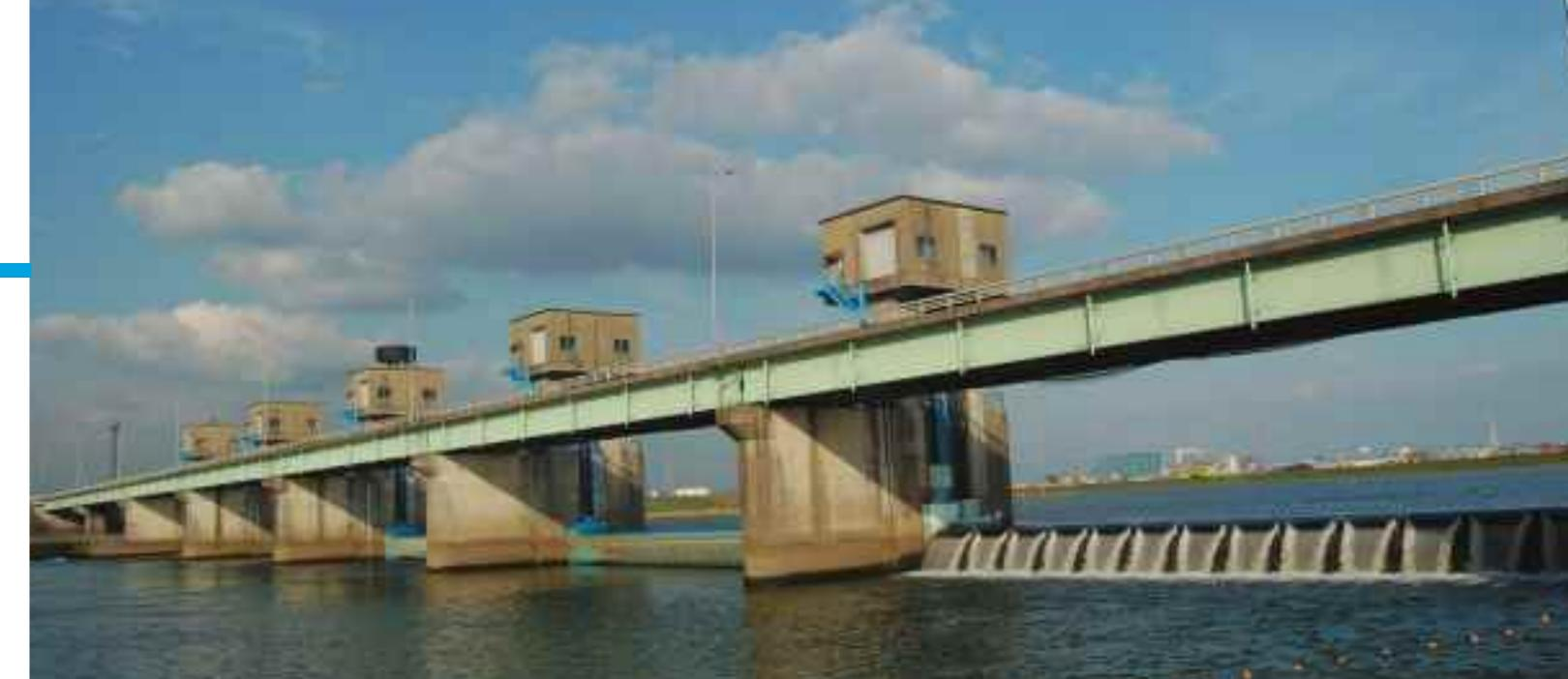
筑後大堰は、洪水を安全に流すために河道整備を行い、洪水の流下を妨げる固定堰(旧上鶴床固)にかわる可動堰として建設されました。
