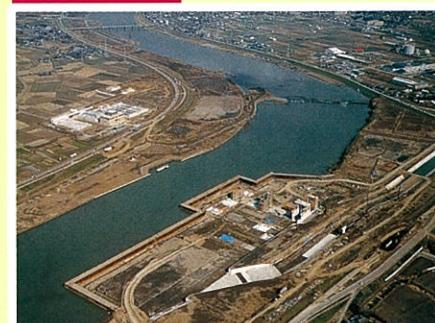
1期工事の残り工事を完成させ、左岸堰柱2基、左右岸橋台2基を施工、ゲート2門の据え付けを行いました。
