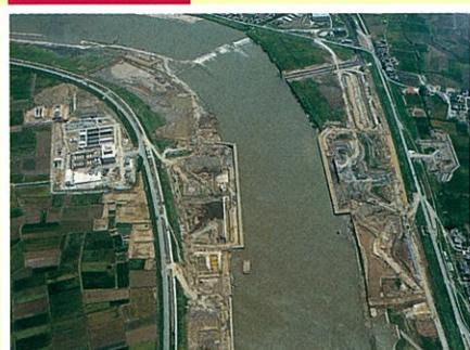
左右岸同時着工とし、右岸側は最小限の施工範囲とし、5月末までに仮締切を撤去しました。
