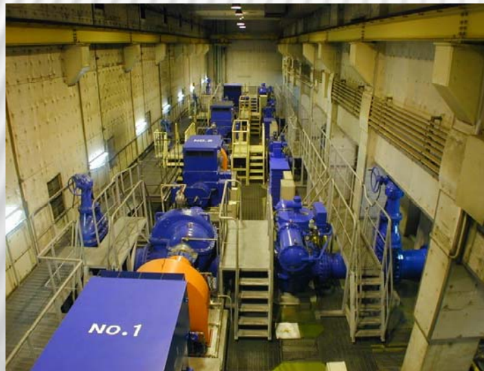
ポンプ場全景
