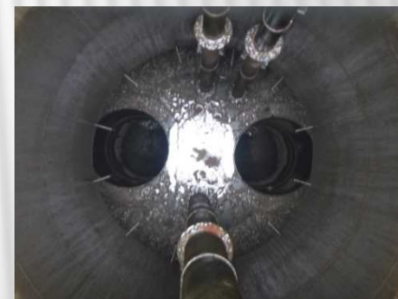
調圧水槽内部 (点検の空水時、通常は満水)
