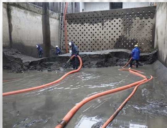
除去作業中(吸引車)
