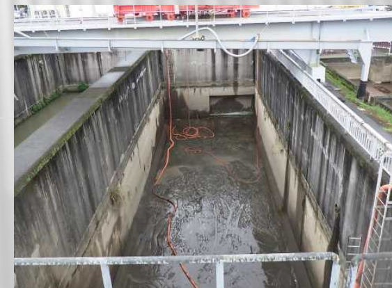
除去作業後(清掃実施前)
