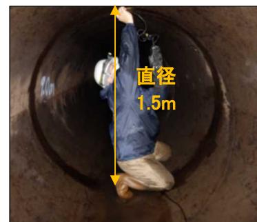
管内(調査状況)
