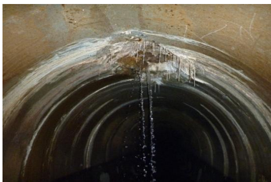
トンネル頂部の欠損
