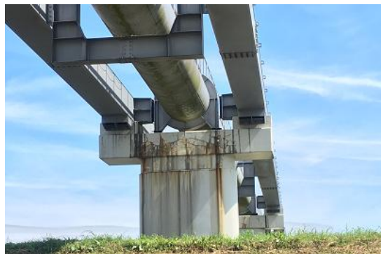
思案橋水管橋下部工のひび割れ
