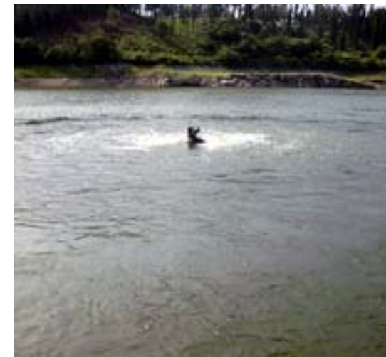
【曝気循環施設の設置例(寺内ダム)】
