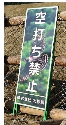
ダンプトラックによる空打ち禁止看板の設置
