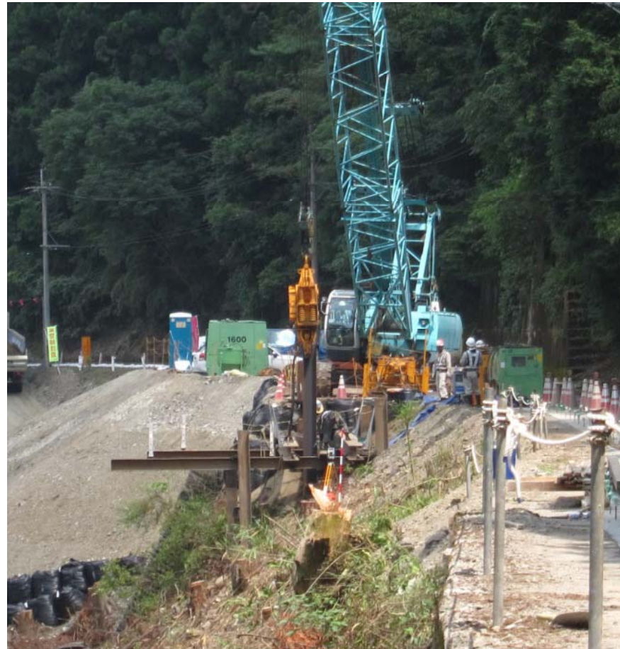
サイクルハンマを用いた杭打ち作業の実施状況
