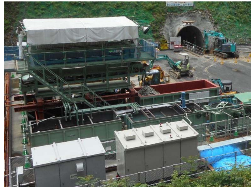
導水施設建設工事の例
