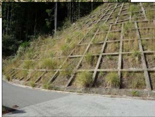
法面緑化状況
