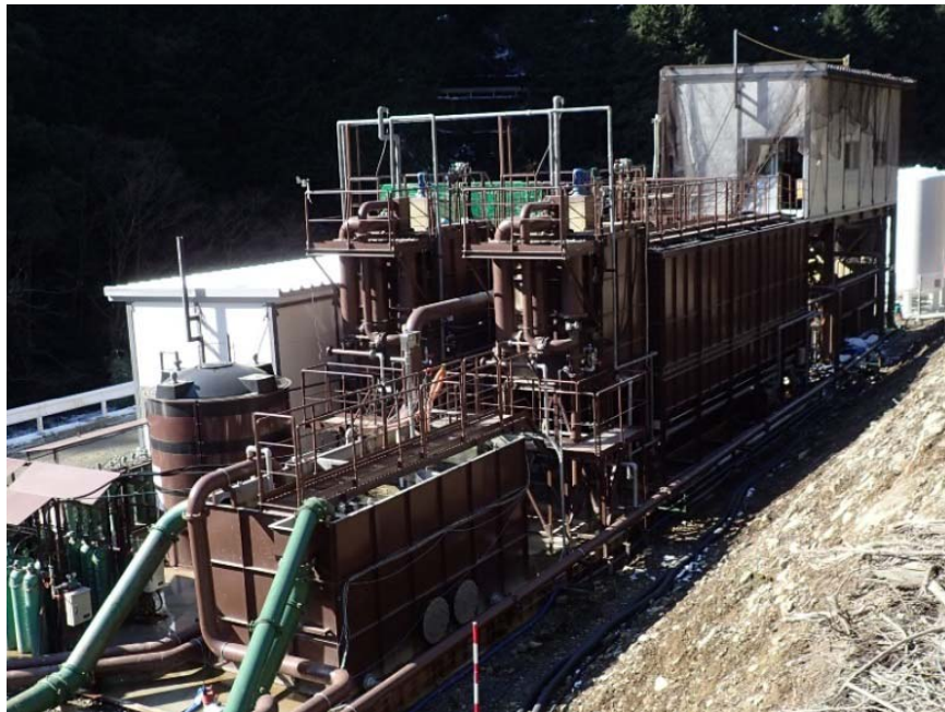
ダム本体建設工事の例
