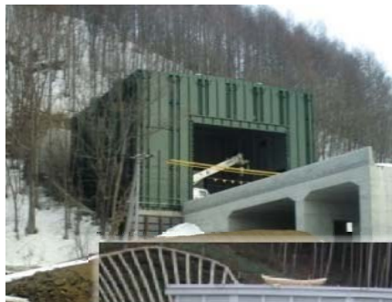
防音シェルターの例 (坑口防音扉設置まで期間)
