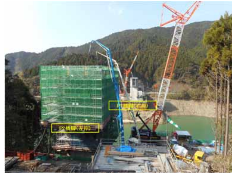
付替国道1号橋工事
