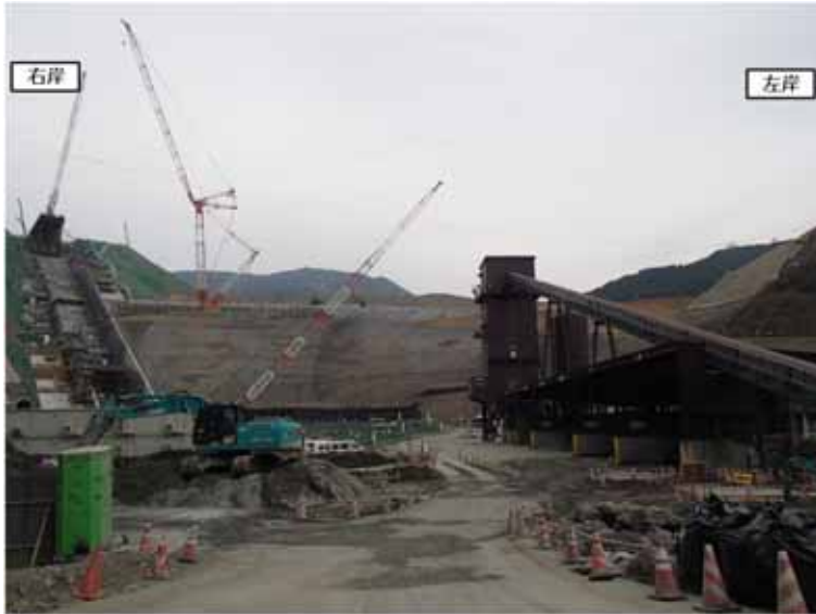
ダムサイト下流より(右側:コンクリート製造設備)
