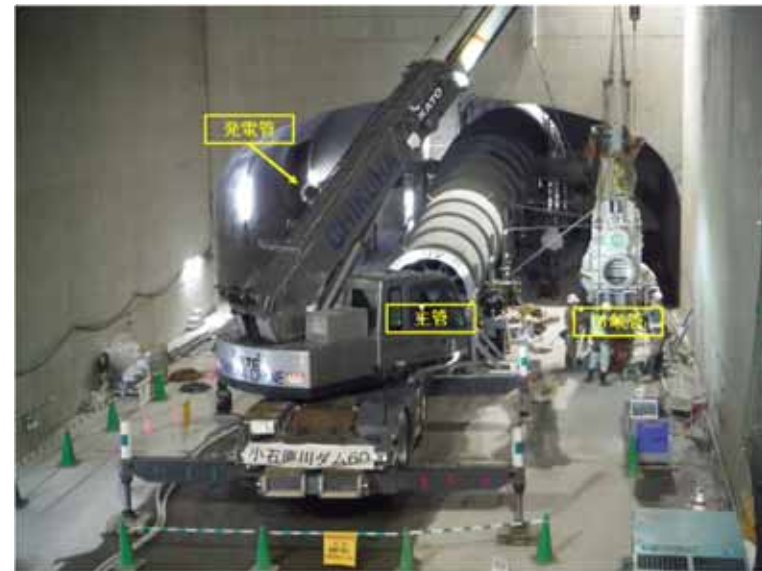
取水放流設備工事(利水放流管据付状況)
