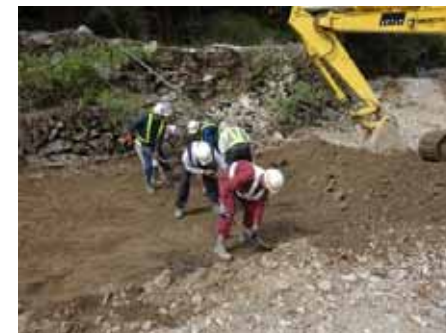
土砂の除去状況(4月)
