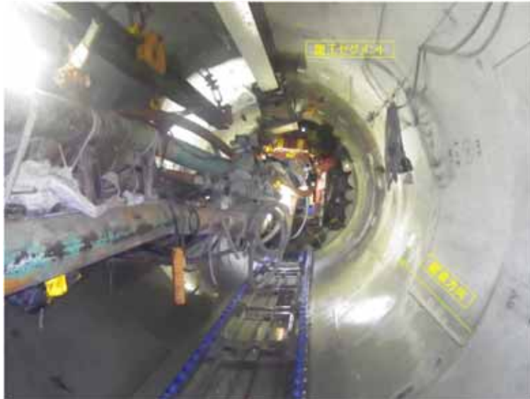
導水施設建設工事(取水工側状況)
