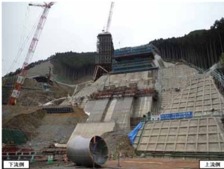
取水放流設備工事(呑口管、充水設備、水位計管据付状況)
