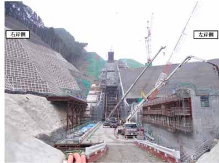
洪水吐き工(シュート部、減勢工の施工状況)
