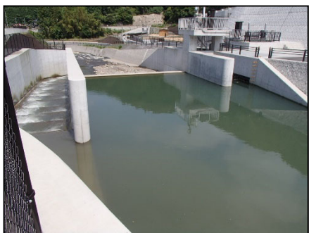
魚道出口と取水堰湛水域(5月)
