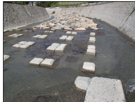
施設下流側水路・自然石区間 (5月)
