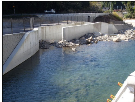
取水堰上流側土石除去(11月)
