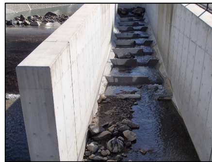
魚道の状況(11月) (土石除去により通水確認)
