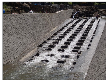
施設上流側水路・根固区間 (5月)
