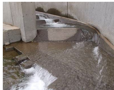
魚道の入口(R3.11月) ※入口部の水深5cm未満、流速230cm/s
