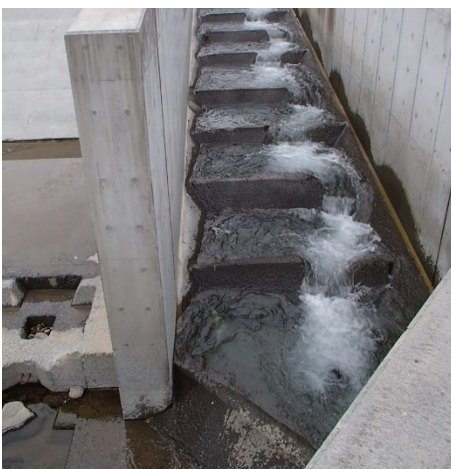
魚道の状況(R3.11月) ※8月の大雨後に土砂が流出し流速が早くなる
