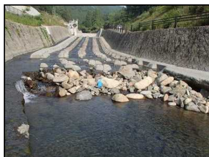
【下流側水路自然石区間と根固区間の境界】 令和2年7月豪雨後に自然石が流出、洗掘により根固ブロックと落差が生じていたが、土石投入により緩和
