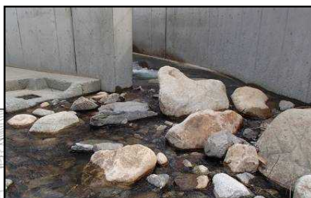
【魚道入口】 令和3年8月の大雨後に魚道と下流水路に落差が生じていたが、土石投入により解消
