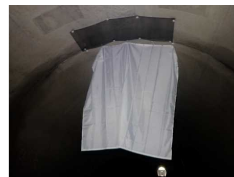
新たに設置したコウモリピット (プラスチックネット+暖簾型)
