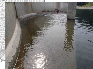
【魚道出口】 石などが撤去し、魚類の通過ルートを確認。堰上流側に堆積していた土石を取り除き下流水路の落差部分に投入
