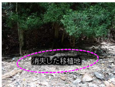
写真 4-22 九州北部豪雨の被害
