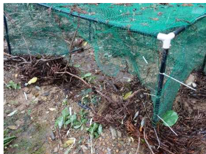
写真 3-81 土砂流入の状況
