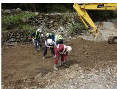
写真 4-16 流入土砂の除去状況
