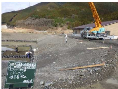
写真 3-32 表土の移植状況
