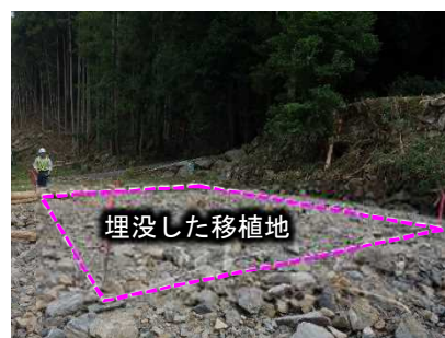
写真 4-15 九州北部豪雨の被害
