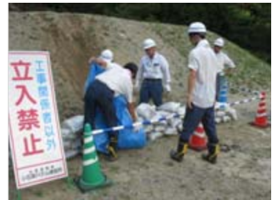
応急対策訓練(土のう・ブルーシート張り)
