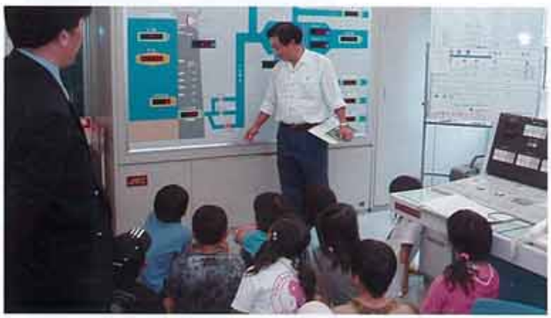
ダム施設を管理する中心部（操作室）です。 ここでダムの水を調節し、下流へ安定した水を供給しています。
