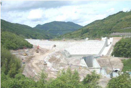
下流側よりダム本体を望む
