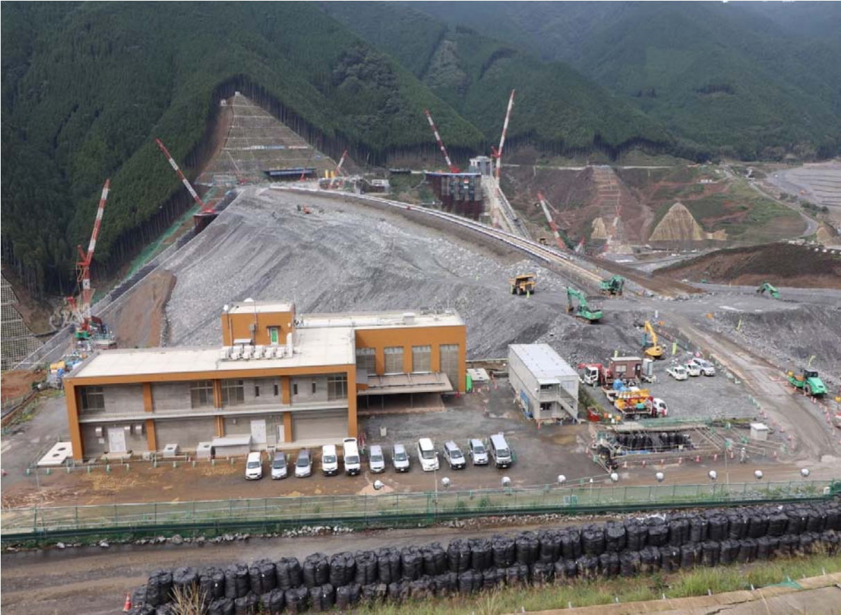
本体建設工事（ダムサイト左岸より）
