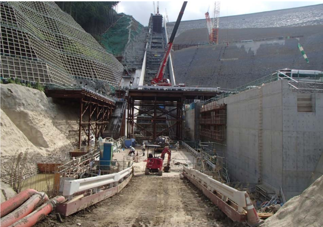
本体建設工事（洪水吐き工：ダムサイト下流より）
