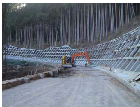
道路の付替の工事（大山ダム）
