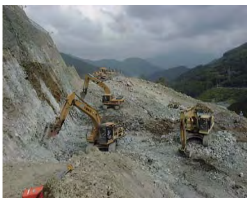
ダムサイトの掘削状況
