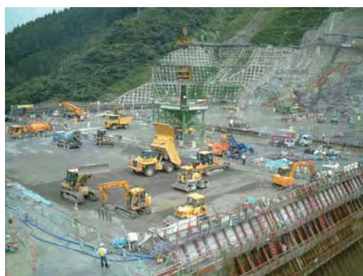
コンクリートの打設状況
