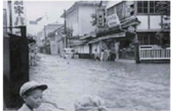
昭和28年 筑後川大洪水（日田市隈町）
