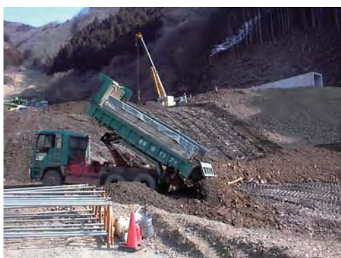
建設発生土受入地の工事（滝沢ダムの例）
