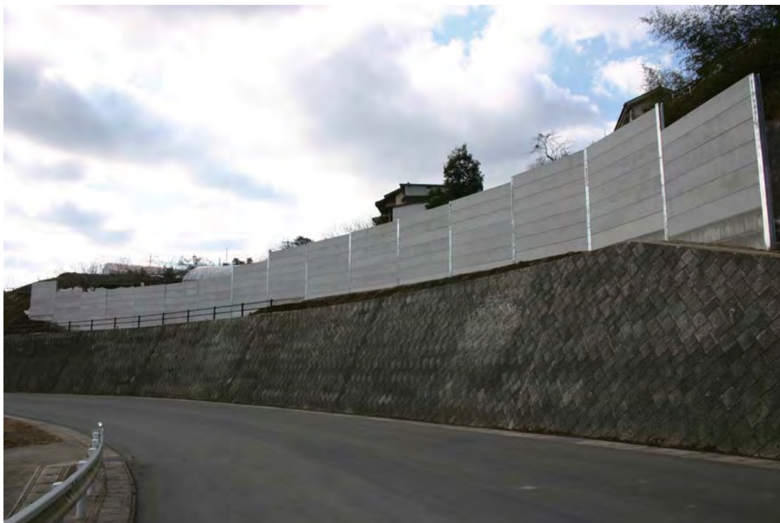
遮音壁設置状況
