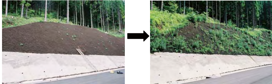
工事用道路における法面緑化状況
