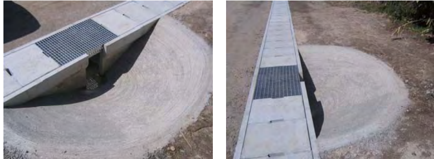
環境側溝の設置状況
