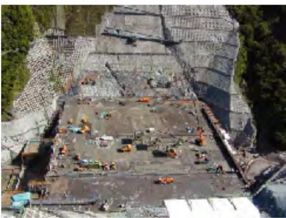
▲ダム堤体の工事（コンクリート打設：滝沢ダムの例）
