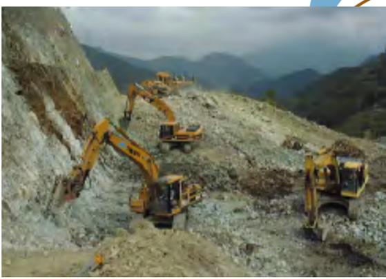
▲ダム堤体の工事（ダムサイト掘削：滝沢ダムの例）
