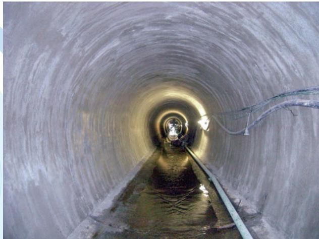
増厚工法で補強した水路トンネル
