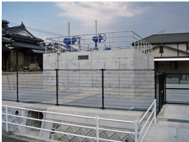
安定通水のため分水工水槽の規模を大型化
