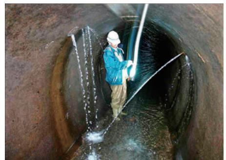
トンネル覆工から漏水している寺内導水路
