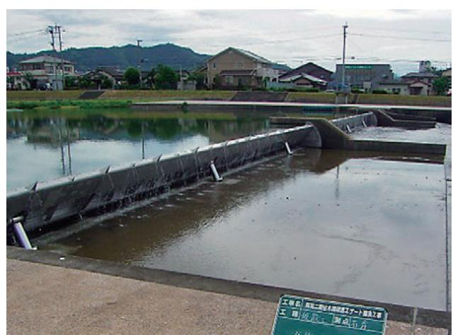
ゲート本体と油圧設備を更新した甘木橋頭首工
