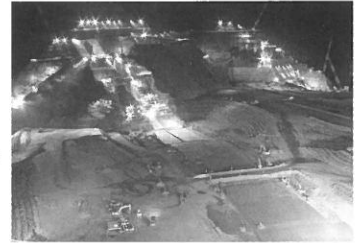
魅了される夜の小石原川ダムの工事現場
