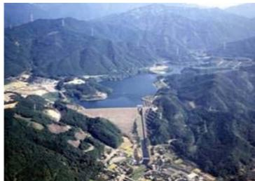
寺内ダムは、福岡都市圏の水がめとして、また両地区平野への農業用水としてつくられました。筑後川水系の他のダムとチームワークを組んで洪水を防いだり、川に一定量の水を常に流し続けています。ダムの特徴は岩や土を積み上げて造るロックフィルダム構造です。周囲の環境と美しく調和しています。
