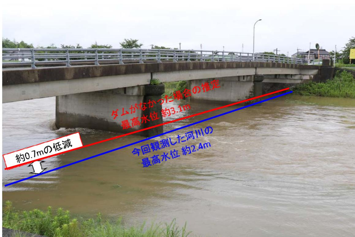
寺内ダムの洪水操作により、河川の水量を調節したことによって、佐田川の金丸橋水位観測所地点で約0.7m河川の水位を低減させ、はん濫注意水位(2.5m)以下に抑えたと推定されます。
