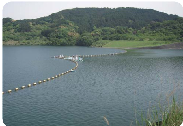
網場（流木止設備）
