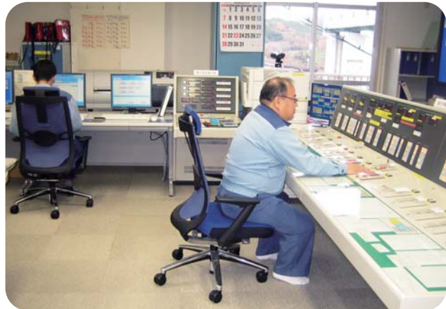
ダム管理用制御処理設備（ダムコン）
