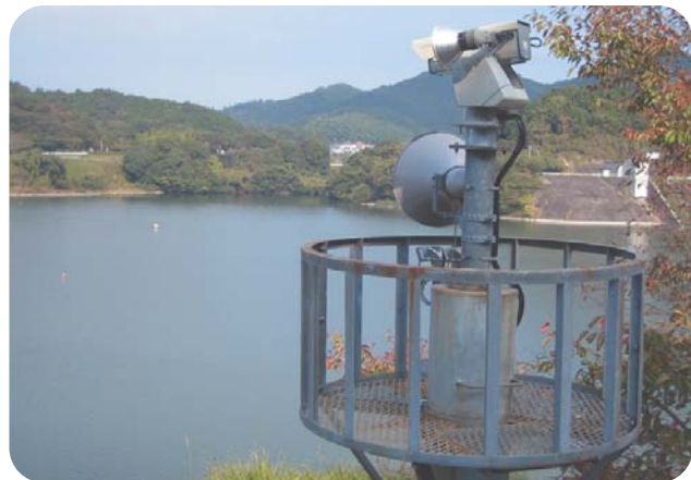
CCTV設備（カメラ）
