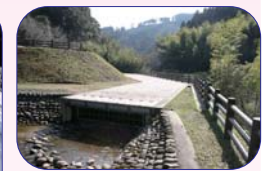
蓋を取付けた状態
