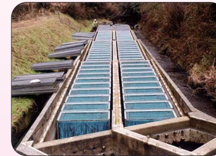
下流側（内部のひも状接触材を撮影）
