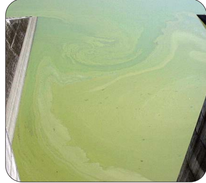
風により洪水吐にアオコが吹き溜まった状態
