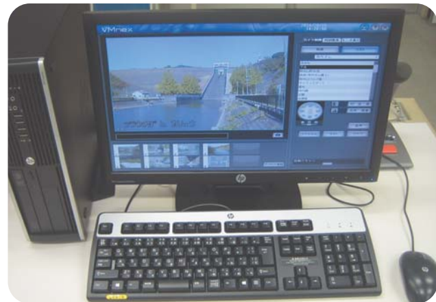
CCTV設備（監視端末）
