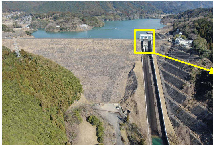
■洪水放流設備
