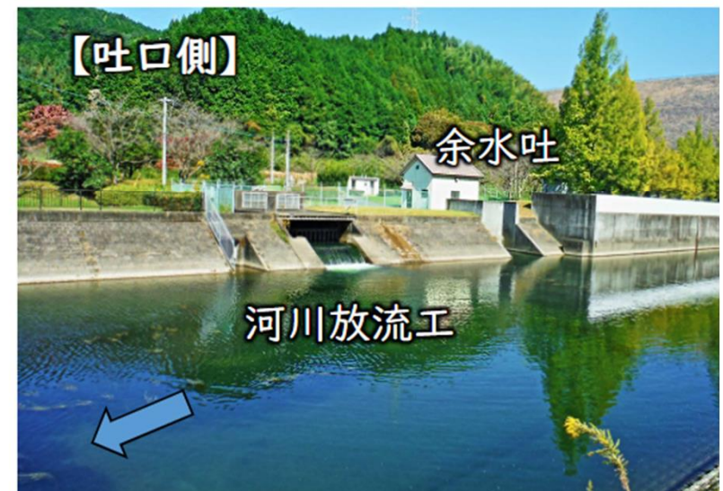
図1-5 取水設備と利水放流設備の概要
