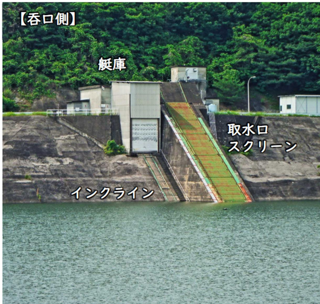
図1-5 取水設備と利水放流設備の概要
