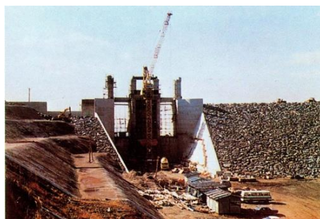
洪水吐(流入部)建設状況 (S51. 11)
