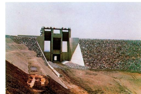
洪水吐(流入部)建設状況 (S52. 3)
