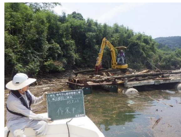
回収作業状況（令和5年7月）
