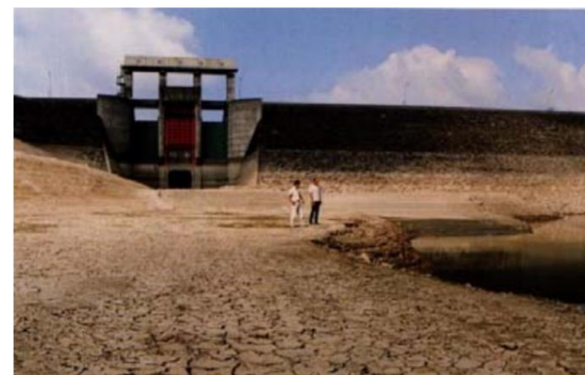
干上がった寺内ダム（平成6年渇水）
