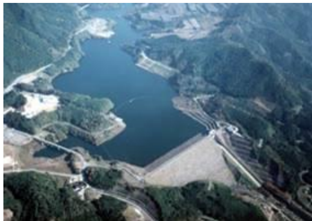
【寺内ダム管理所】 福岡県朝倉市荷原1516-6
