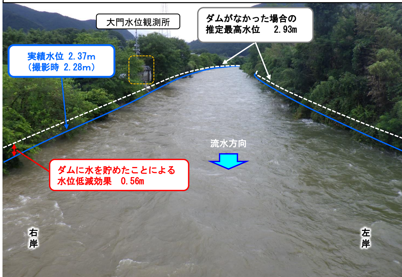
大門地点 現地写真（洪水時）（令和7年7月15日11時00分頃撮影）
