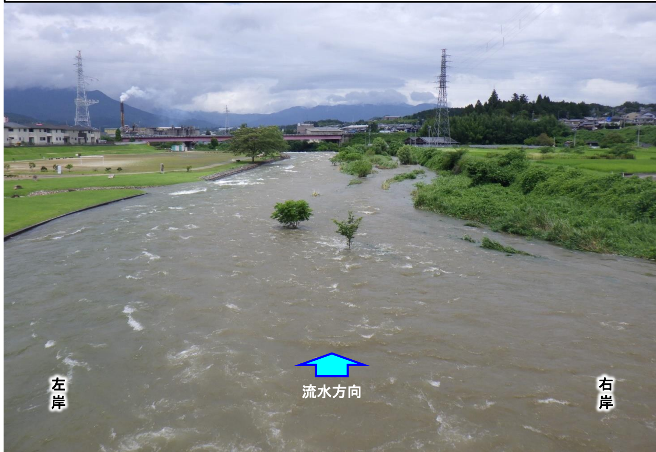
阿木川公園 現地写真（洪水中）（令和7年7月15日11時00分頃撮影）
