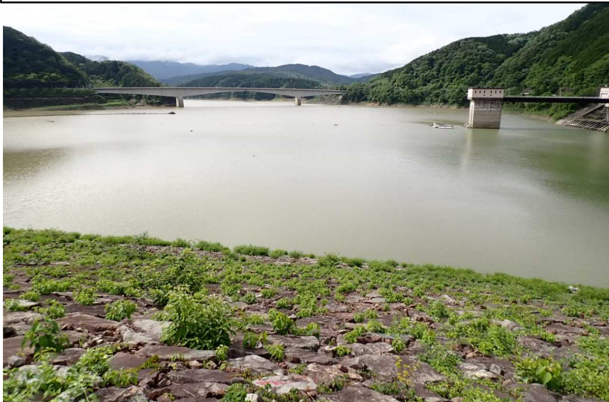
阿木川ダムの貯水池状況写真（洪水後）（令和5年6月3日9時10分頃撮影）
