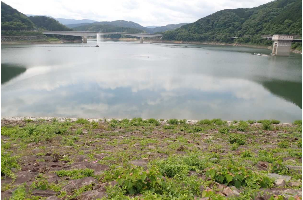
阿木川ダムの貯水池状況写真（洪水前）（令和5年6月1日10時00分頃撮影）
