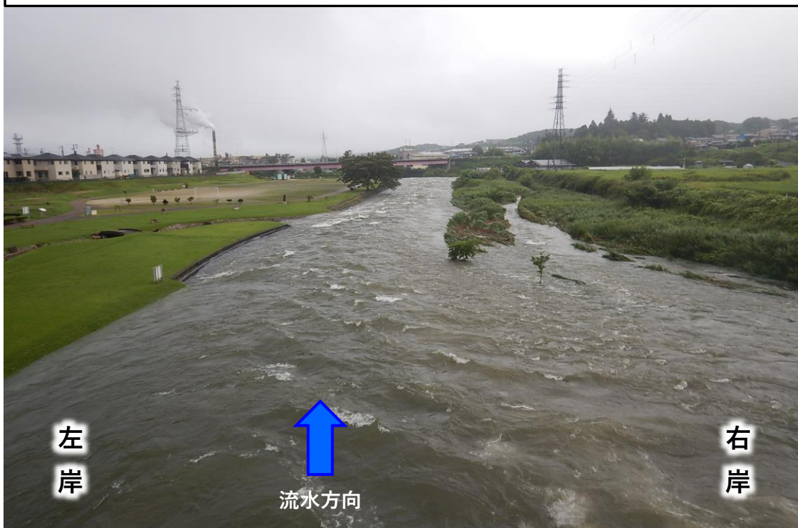
阿木川公園 現地写真（洪水中）（令和6年7月17日5時50分頃撮影）
