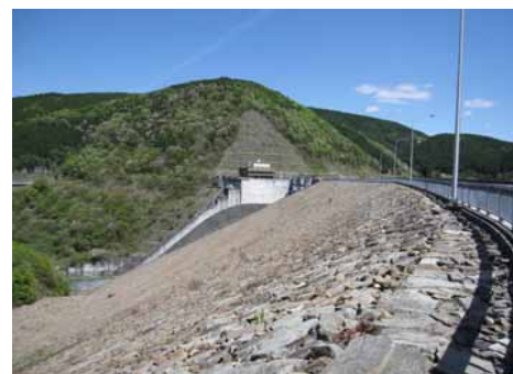
②阿木川ダム堤体(ダム左岸より)
