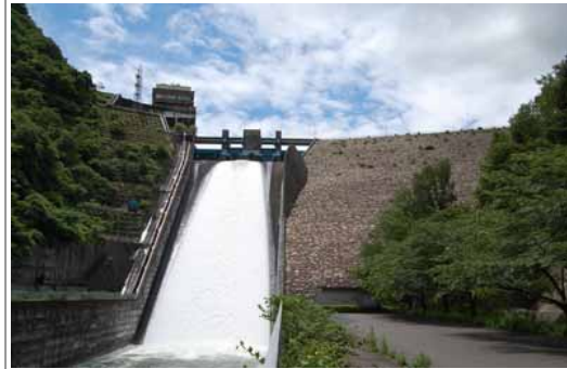
①阿木川ダムゲート放流(ダム下流よ)
