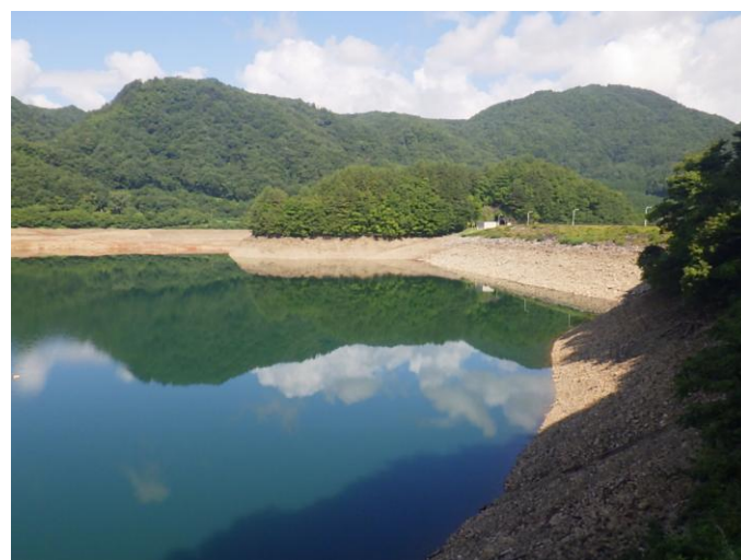
令和8年9月1日 ダム右岸より堤体
