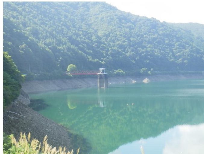
令和8年9月1日 ダム右岸取水塔
