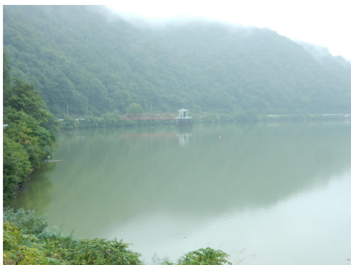
令和8年9月10日 ダム右岸取水塔
