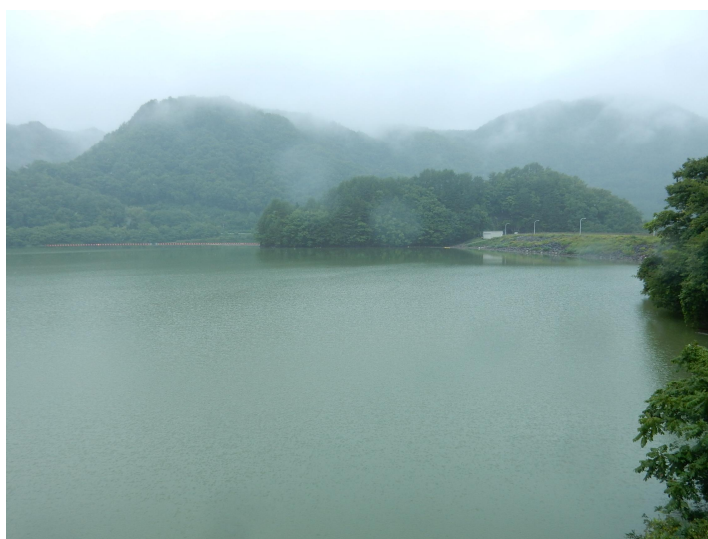
令和8年9月10日 ダム右岸より堤体
