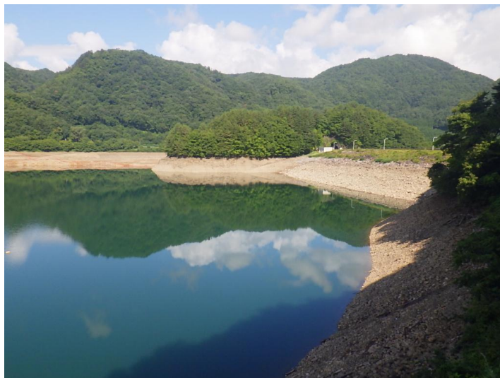
令和8年9月1日 ダム右岸より堤体
