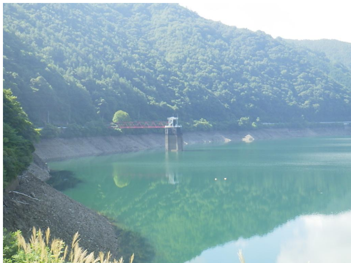
令和8年9月1日 ダム右岸取水塔
