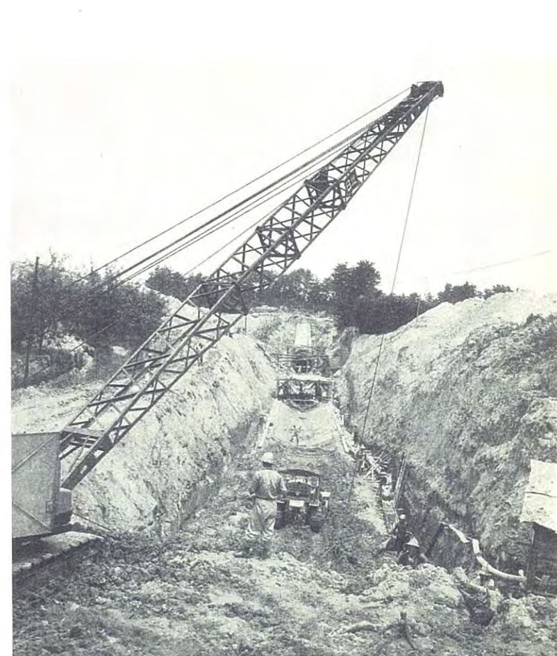
キャリオールスクレーパーによる掘削のあとからベッドが打たれてゆく
