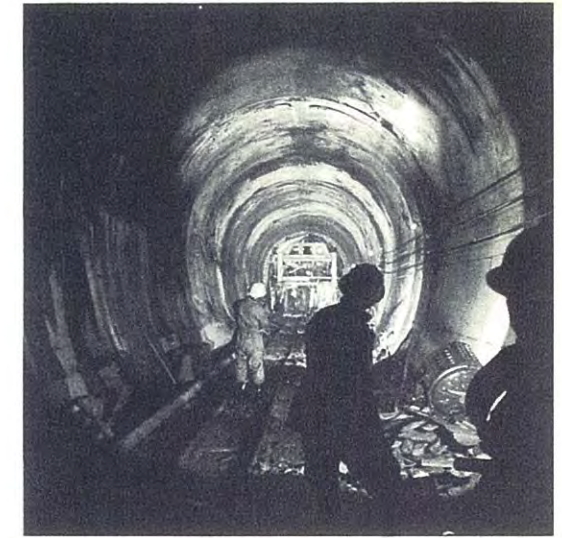
トンネルのコンクリート巻立てをスピードアップするスチールフォーム (一日の巻立能率10m - 12m)
