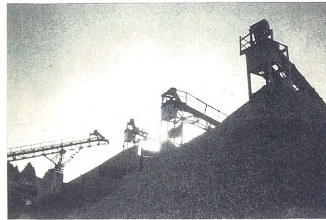
クラッシング・プラント（兼見トンネル第1横坑）
