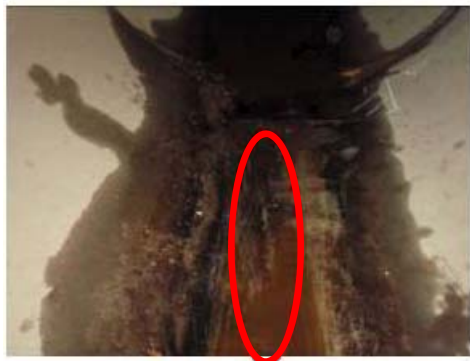
管底部の縦断クラック
