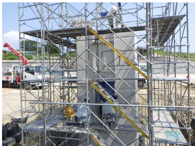
ゲート設置状況
