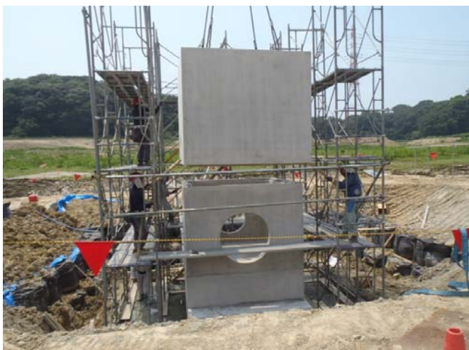
ゲート柵設置状況
