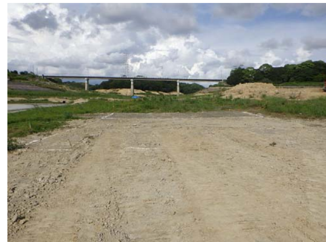
地盤改良完了
