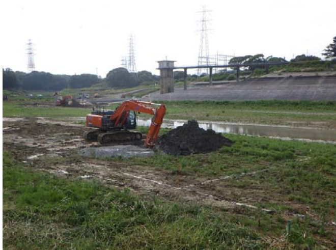
改良材混合状況
