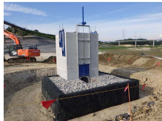
ゲート柵設置完了
