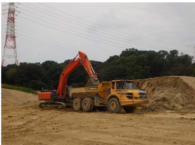
盛土材積込状況
