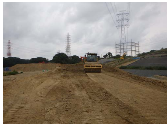
盛土材転圧状況
