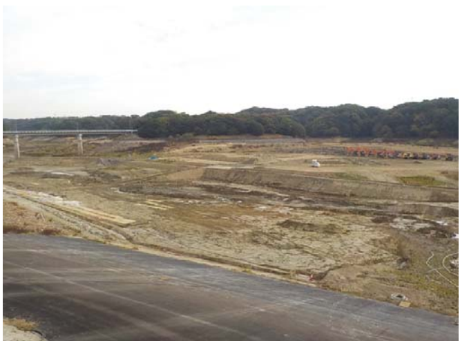
工事用道路造成完了
