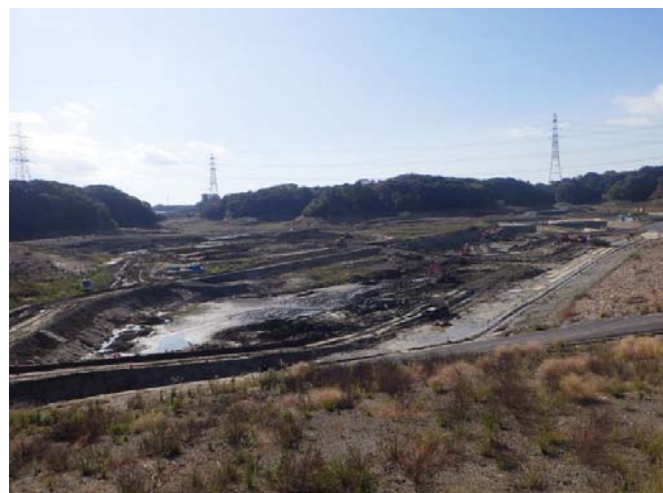
工事用道路造成完了
