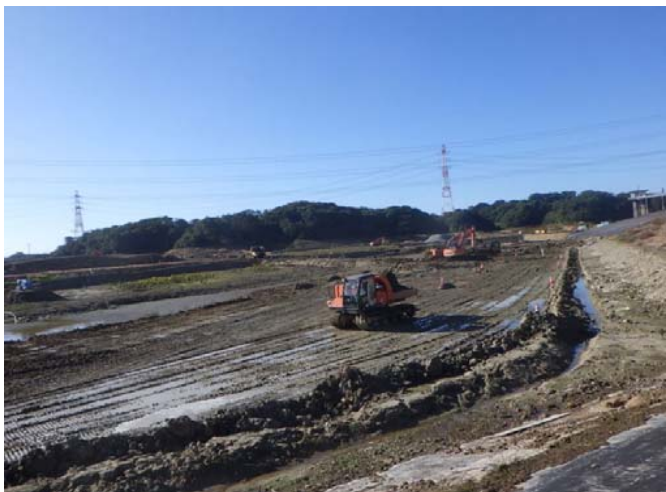
堤体掘削状況
