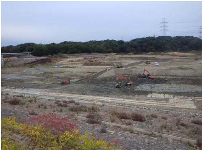
堤体掘削状況
