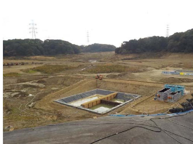
沈砂池C造成完了
