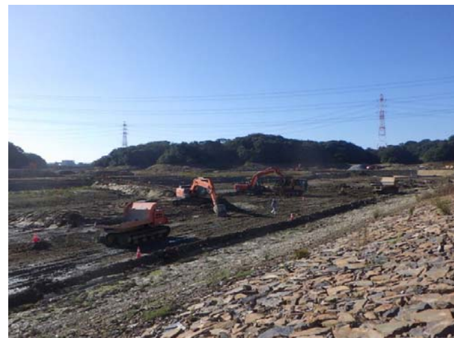
堤体掘削状況
