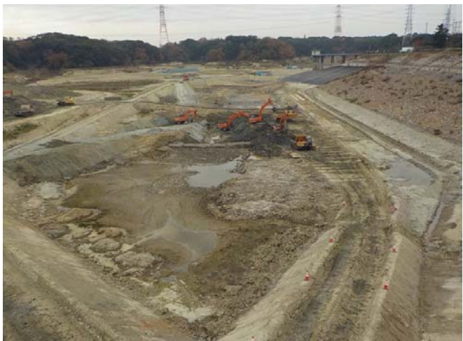
堤体掘削状況
