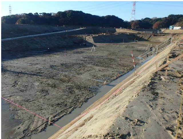
堤体掘削完了
