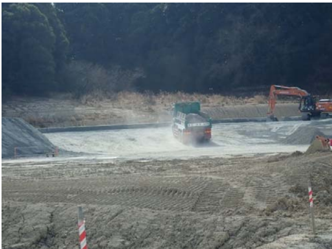
砕石搬入状況
