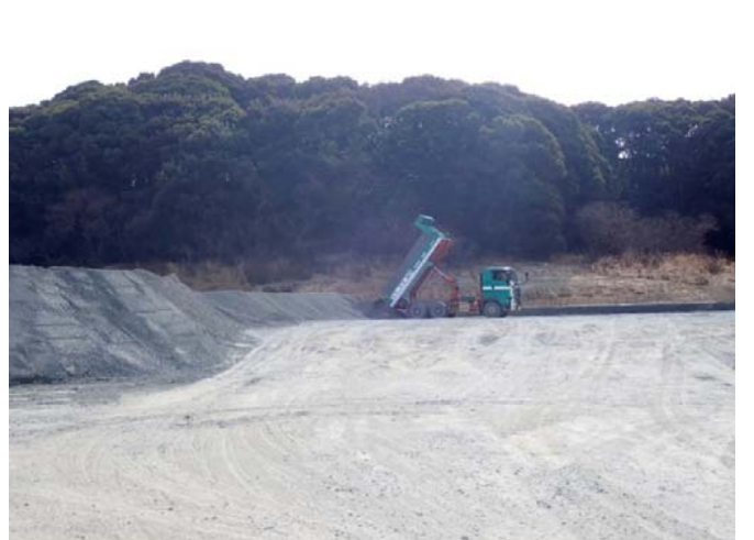
砕石搬入状況
