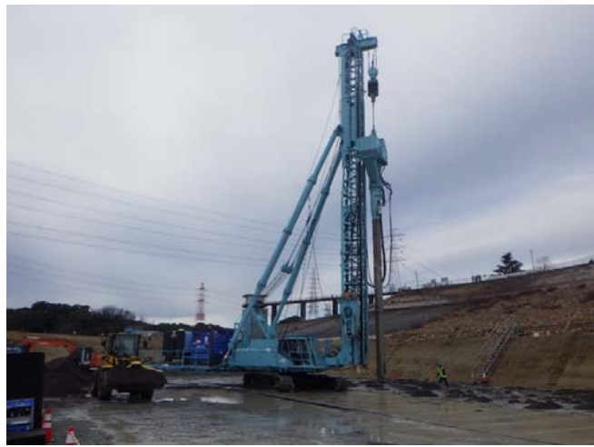
サンドドレーン施工状況
