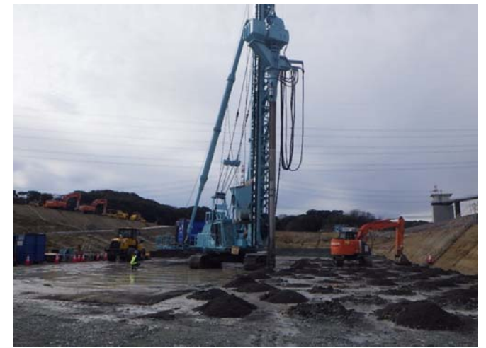
サンドドレーン施工状況
