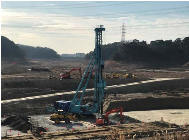
サンドドレーン施工状況
