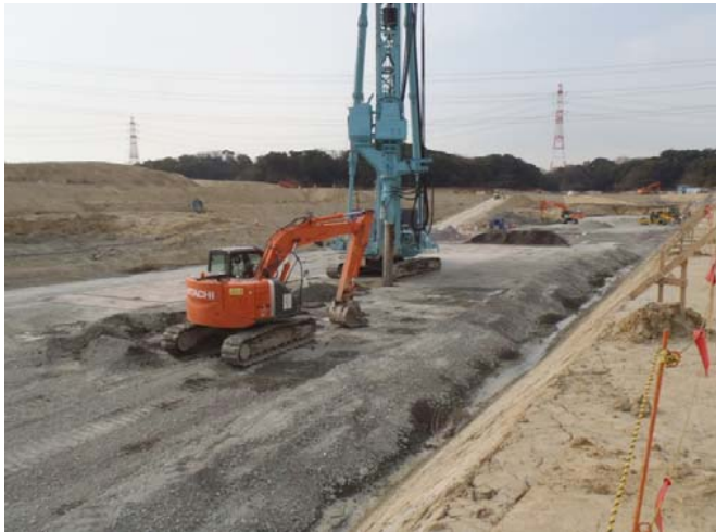
サンドドレーン施工状況
