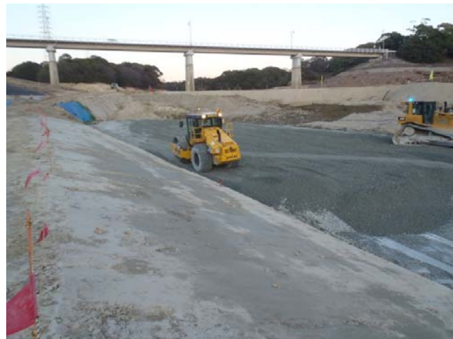
砕石締固め状況
