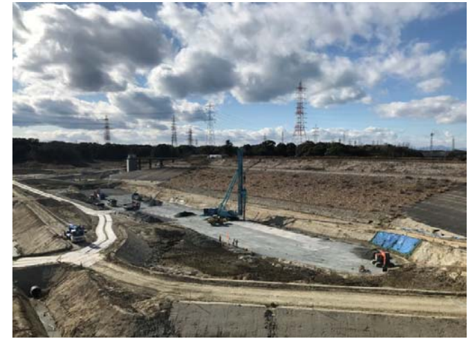
サンドドレーン施工状況
