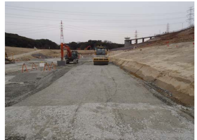
砕石締固め状況
