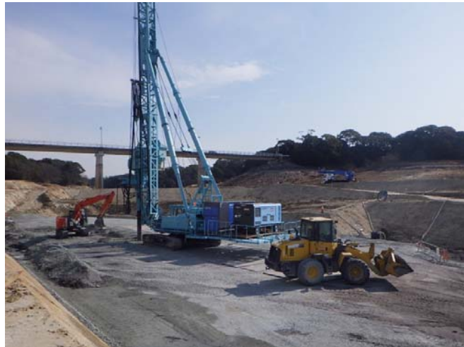
サンドドレーン施工状況
